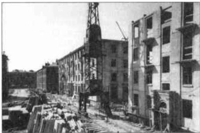
Москва. Хорошевское шоссе. Строительство крупнопанельного дома. 1 сентября 1954 г.
